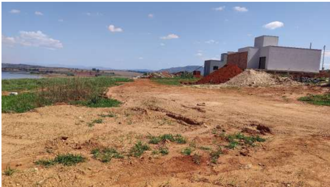
Foto 01: Terreno da construção do Estacionamento
