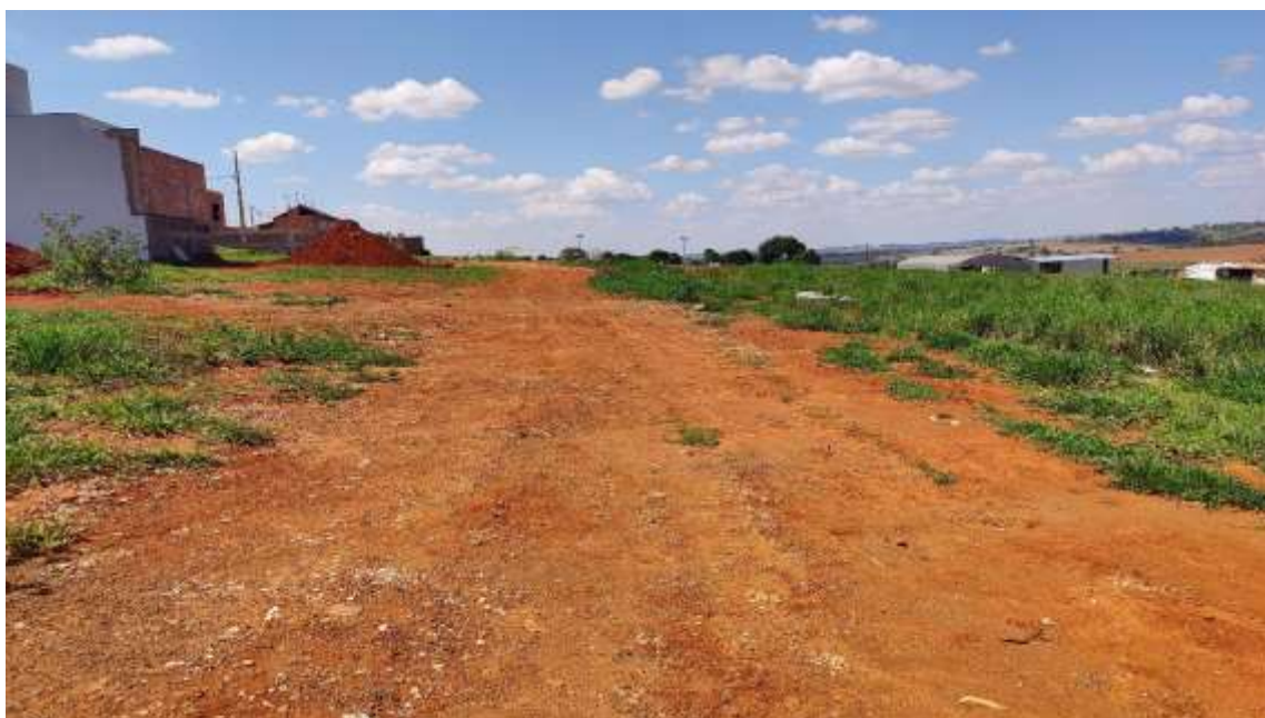
Foto 02: Terreno da construção do Estacionamento
